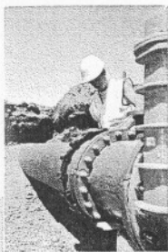
Notre couverture Installation de réseaux
