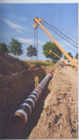
Notre couverture Installation d'un aqueduc en fonte à Fontainebleau.
